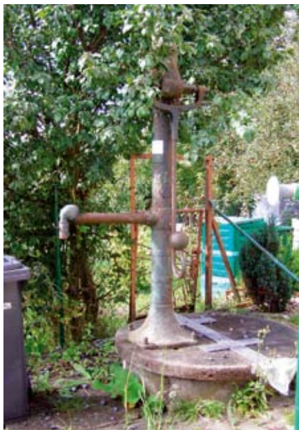
Pumpa na začátku ulice
