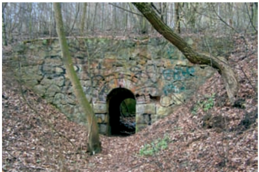
Propustek na staré trati mezi mostem a jehnickou zastávkou
