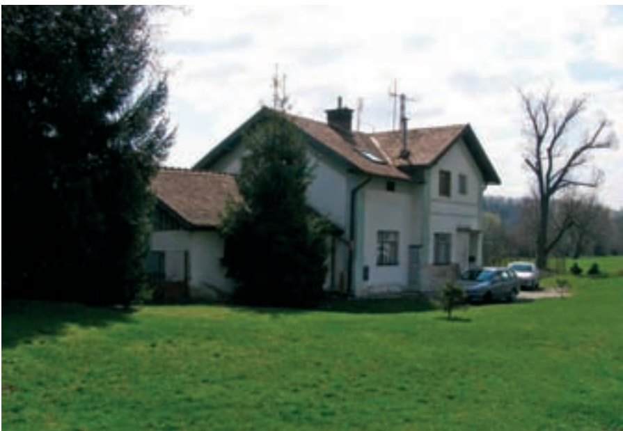
Bývalá nádražní budova v Řečkovicích ulice Cupáková
