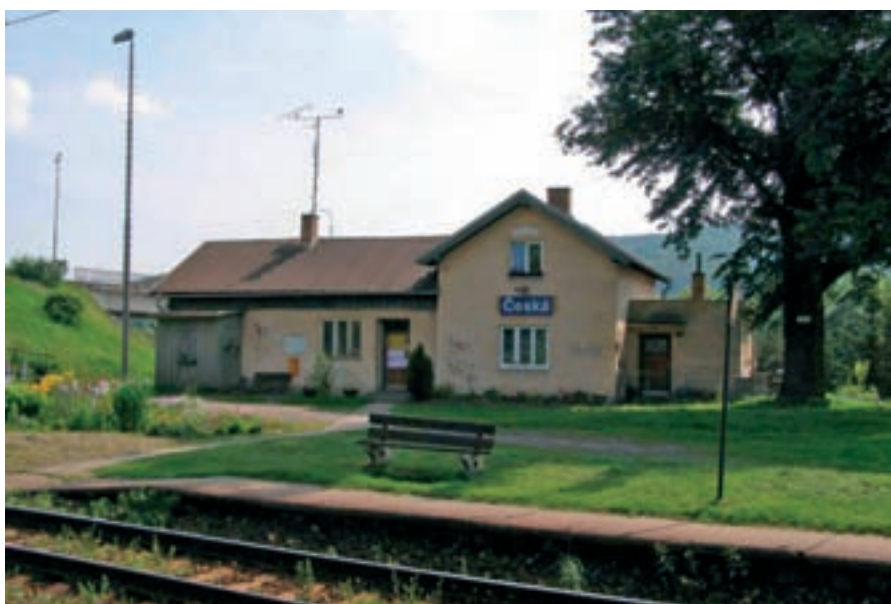
Zastávka Česká původní budova
