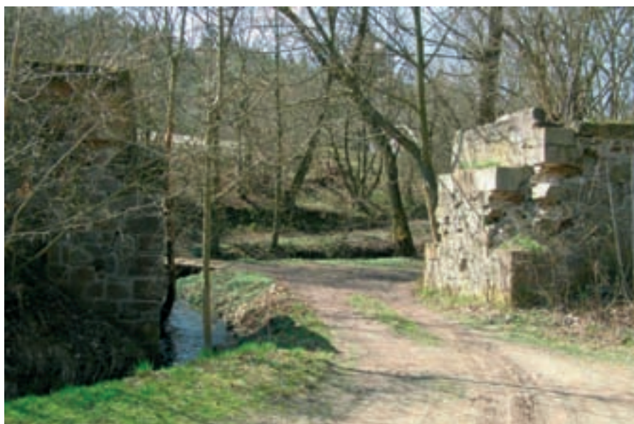
Zbytek mostu, pohled z cesty od jehnické zastávky do Lelekovic
