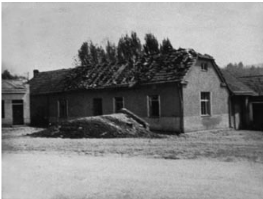
Dům pana Václava Kolaříka poškozen dělostřeleckou palbou
